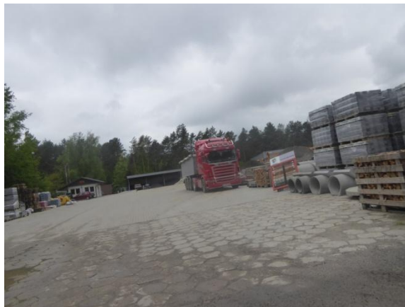
Fot. 3.6 Skład budowlany w miejscowości Obrówka kolidujący z wariantami południowymi (km ok. km 3+100 str. L W3, W4)
