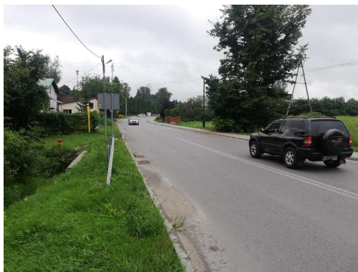
Fot. 2.4 Przebieg istniejącego gazu wysokoprężnego – okolice ronda w km ok. 5+500
