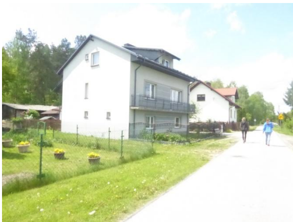
Fot. 3.7 Zabudowa w rejonie miejscowości Majdan na końcowym odcinku wariantów południowych (granica Lasów Janowskich) (km ok. 5+700 str.P W3; 6+500 str.L W4)
